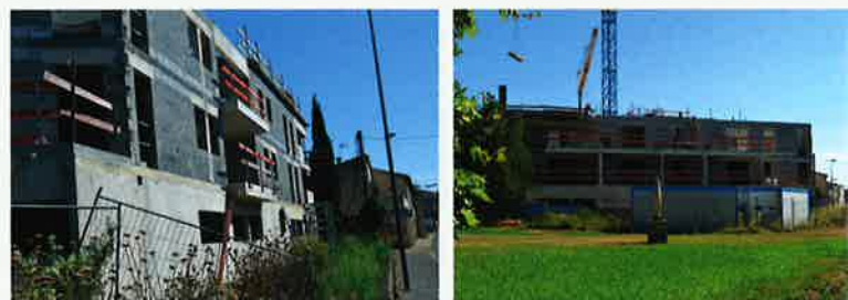
Construction des logements aidés
