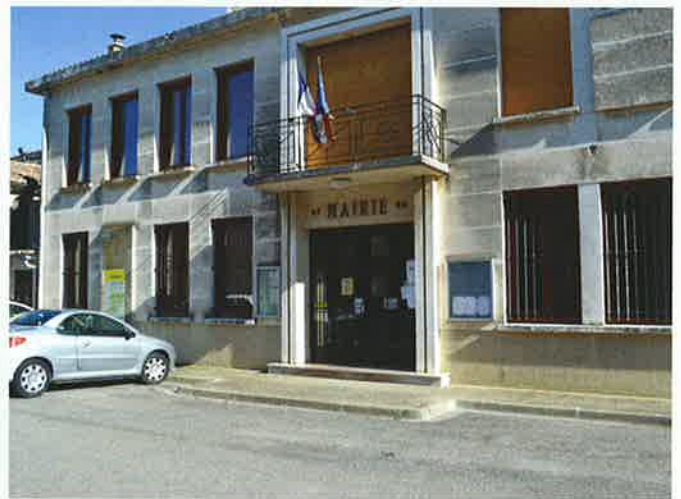
Nouvelles fenêtres de la mairie
