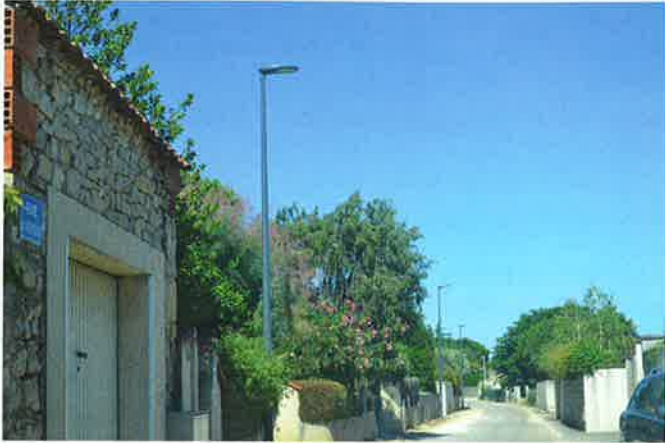
Rue débarrassée des câbles et supports
