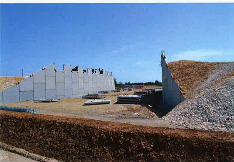
Futur pont de la route de Redessan au-dessus et voie ferrée au-dessous
